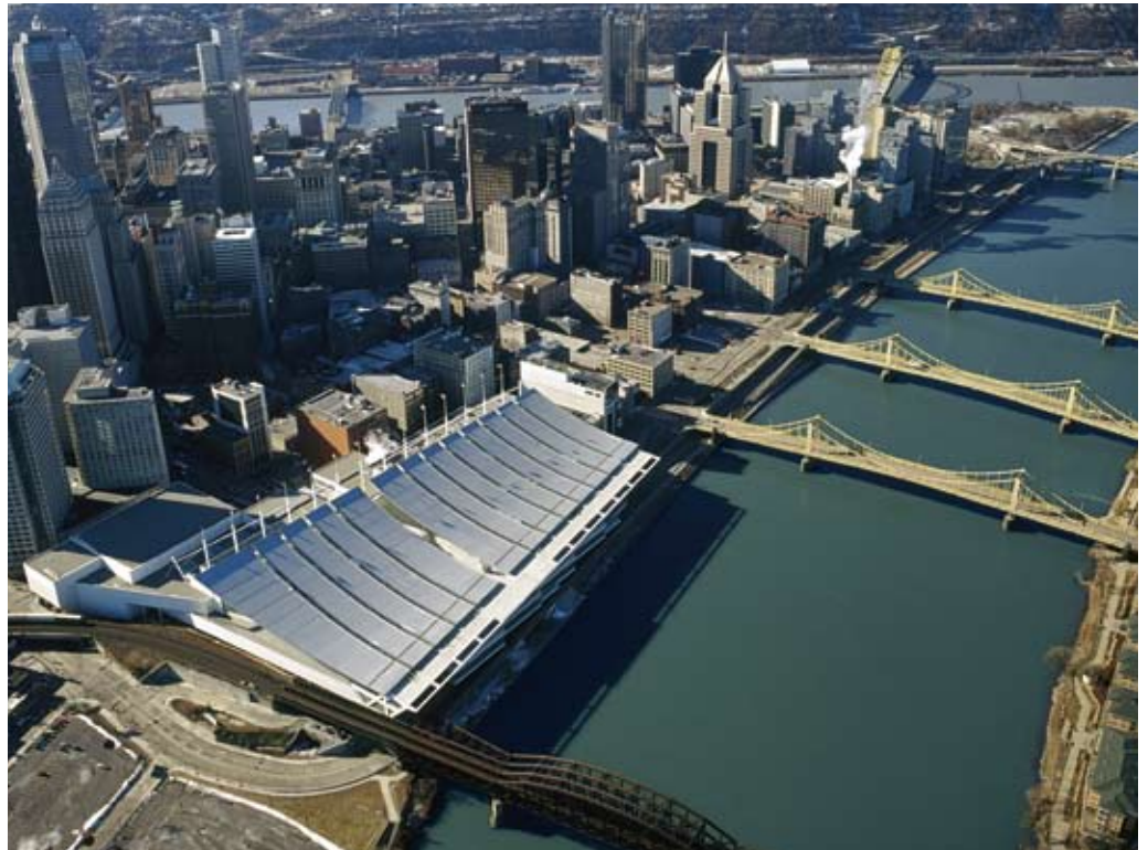
ピッツバーグコンベンションセンター
