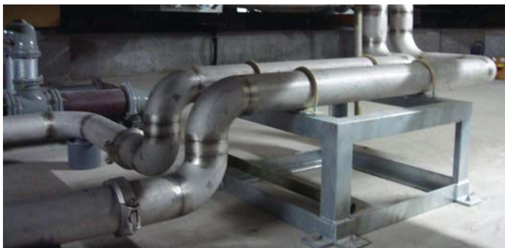
日本でビルの配水管専用に使われているステンレス鋼
