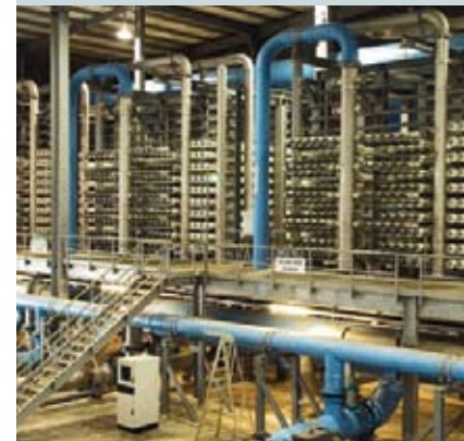
海水淡水化プラントは通常、オーステナイト系及び2相ステンレス鋼を使用。
